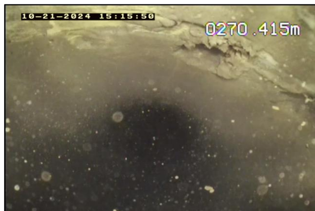
FOTO 15 - Visada de fundo – possível rompimento.
