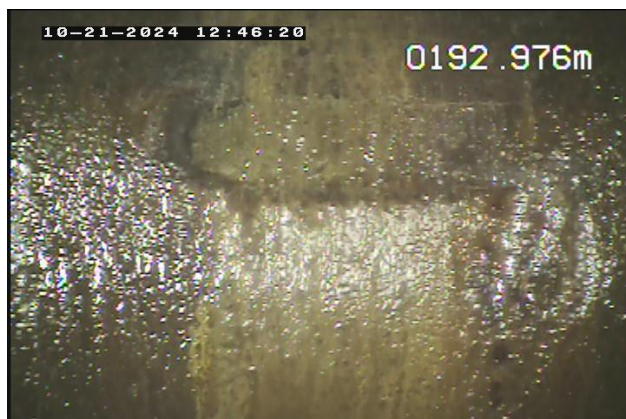
FOTO 07 – Visada lateral – marca do flange no tubo liso.
