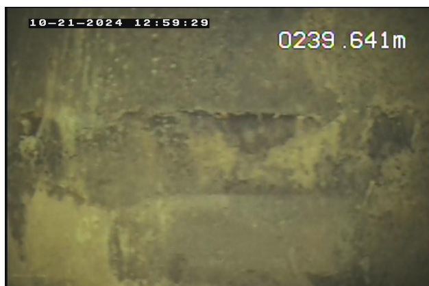
FOTO 11 –Visada lateral – marca do flange no tubo liso.
