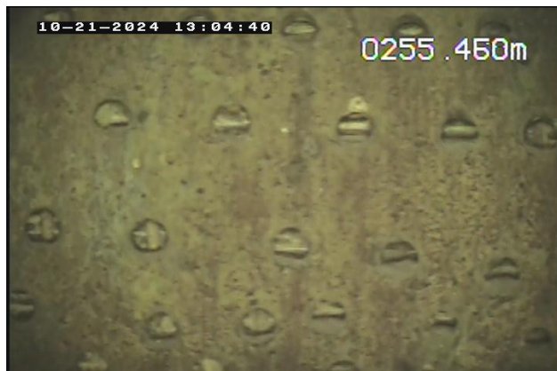
FOTO 13 – Visada lateral – filtro jaquetado.
