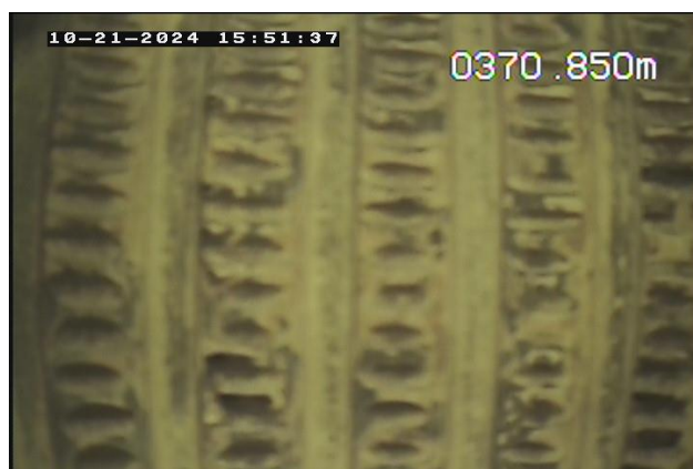
FOTO 21 - Visada lateral – filtro Ø 4" colmatado.
