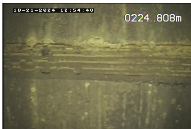
FOTO 10 - Visada lateral – união entre tubos lisos.
