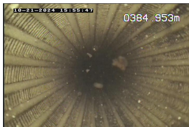
FOTO 22 - Visada de fundo – filtro Ø 4" colmatado.
