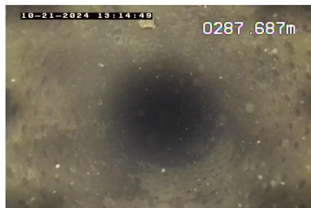
FOTO 17 –Visada de fundo – filtro jaquetado.
