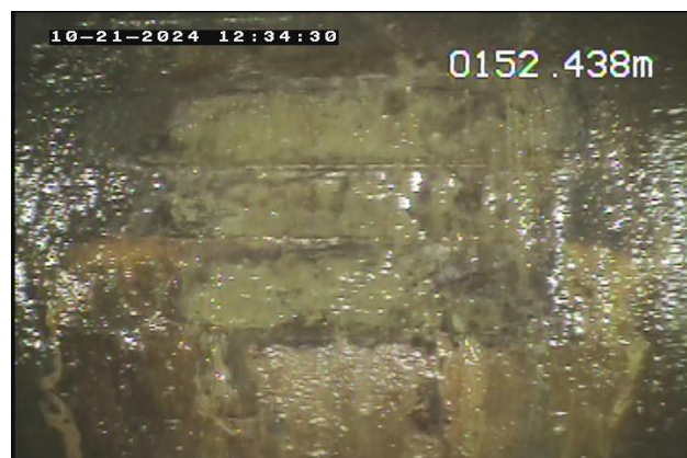
FOTO 06 – Visada lateral – marca do flange no tubo liso.
