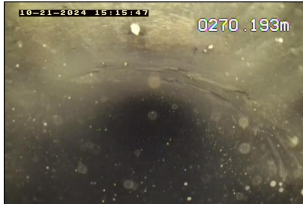
FOTO 14 – Visada de fundo – possível marca do flange na zona de rompimento.
