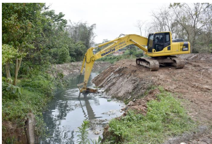
IMAGEM 5: Equipamento do tipo Escavadeira Hidráulica sobre esteira
