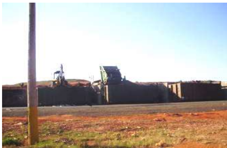
Foto 8.1.1.2-5 Vista da estação de transbordo de RSD
