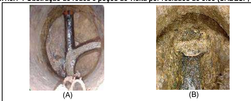
Figura 8.1.8.1-1 Obstrução de redes e poços de visita por resíduos de óleo (SABESP, 2011)
