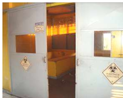
Foto 8.1.4.3-2 Abrigo de armazenamento temporário de RSS
