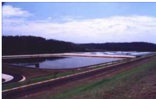
Foto 6.1.1-3 Lagoa de Sedimentação
