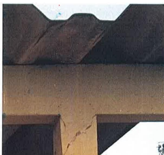
Foto: 2 e 3: Detalhe das Trincas e rachaduras presentes na Viga e no Pilar da Cobertura da Estrutura
