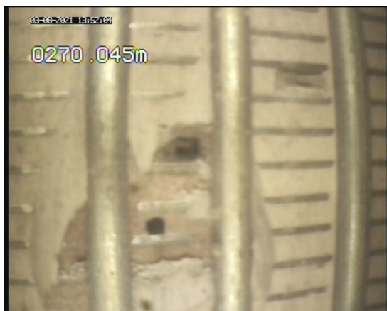
Foto 19: Tubo Espiralado Colmatado e com furos.
