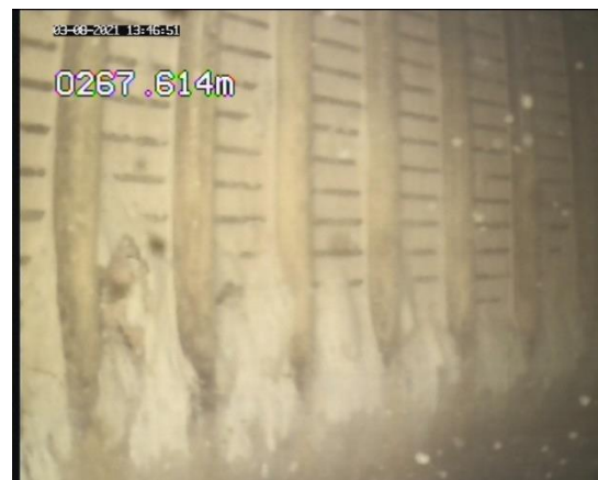
Foto 18: Tubo Espiralado Colmatado.
