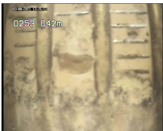
Foto 15: Tubo Espiralado Colmatado e com furos.
