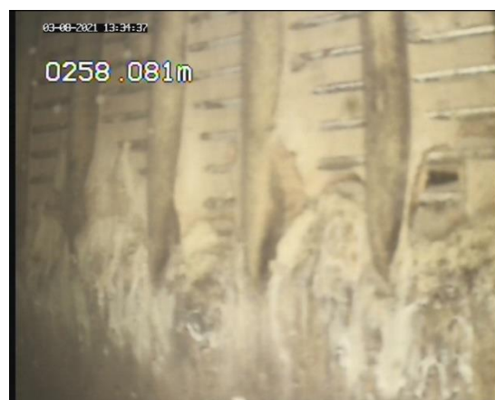
Foto 16: Tubo Espiralado Colmatado e com furos.
