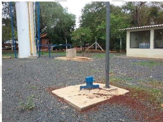
**Figura TEC 2 - Poço Tubular Profundo Assentamento Bela Vista**
