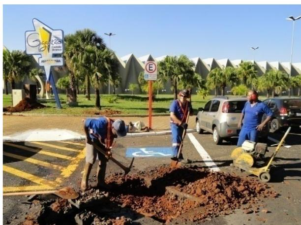
Figura 7.2.: Serviço de manutenção de redes de água – Processo Distribuição de Água
